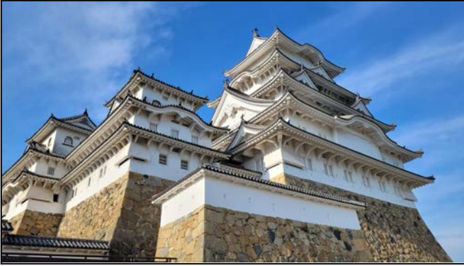
Photographie prise du Château d'Himeji
